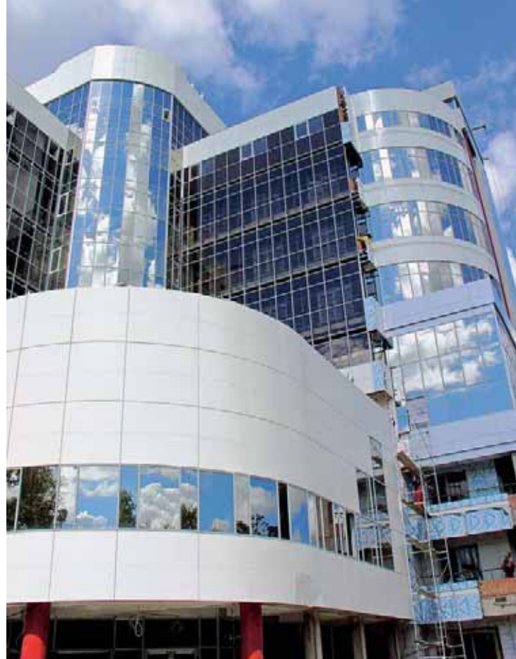
Единый центр управления перевозками (ЕДЦУ), г. Хабаровск. Внутренняя окраска - Луя, Гармония, Ремонтти-Ясса.
