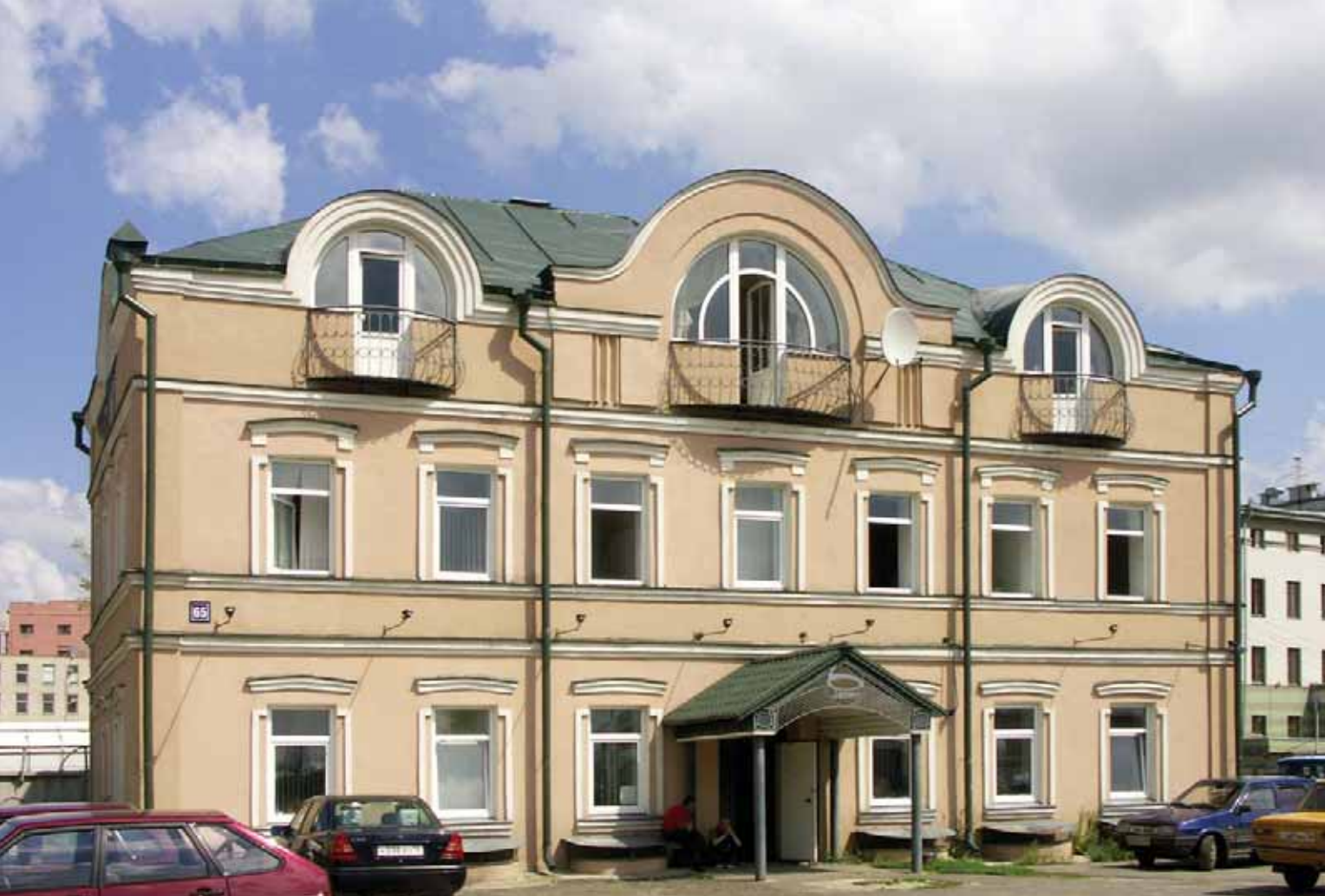
Здание офиса фирмы Ресхил, г. Казань. Краска Миранол и Кивитекс.
