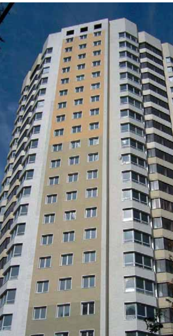
Высотное жилое здание на ул. Беломорской. Окраска плиток Мраморок произведена краской Новасил.
