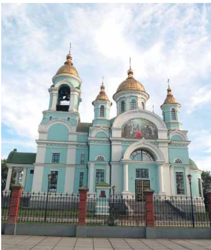
Церковь Сергея Радонежского, г. Нижний Тагил. Система Новасил.
