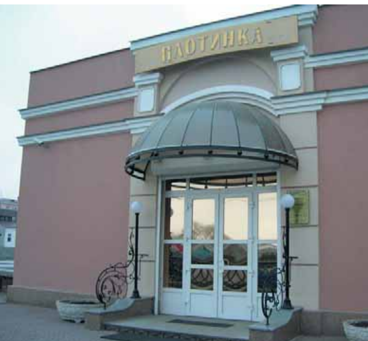
Кафе Плотинка, г. Екатеринбург. Фасад - система Новасил, цоколь - краска Юки.
