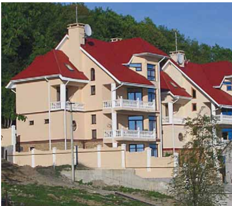
Район Старая Мельница, жилой дом, г. Сочи. Фасад – система Новасил, цоколь – краска Юки.
