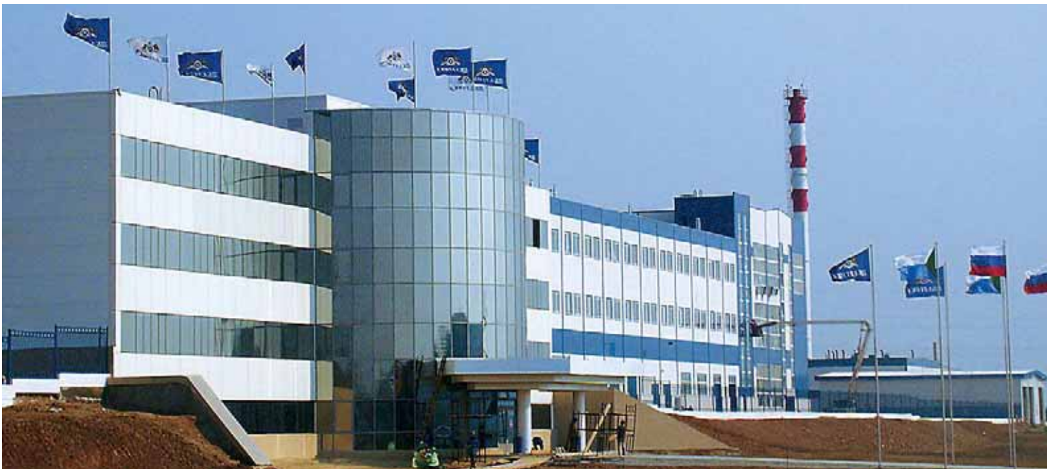
Завод Балтика. г. Хабаровск. Внутренняя окраска металлических поверхностей – краска Миранол.
