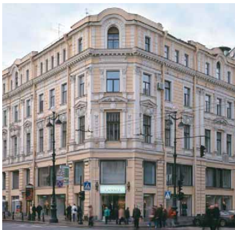
Невский пр., д. 16, г. Санкт Петербург. Фасадная краска Кивитекс.
