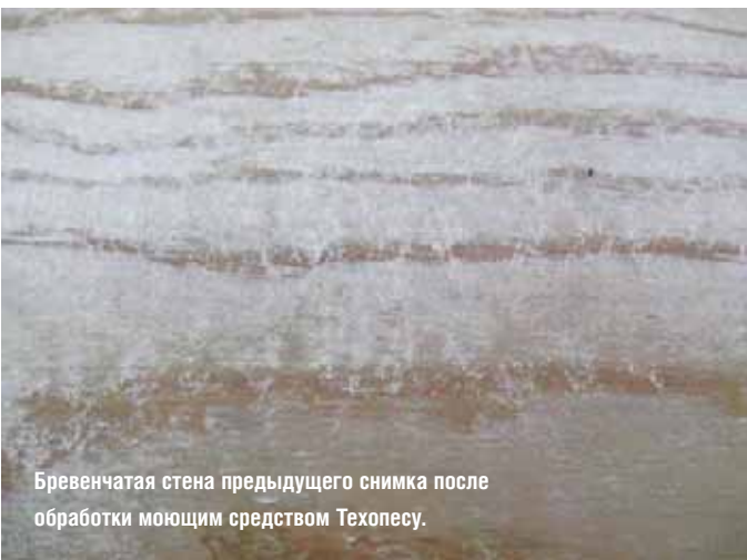
Сильно заплесневелая бревенчатая поверхность.
