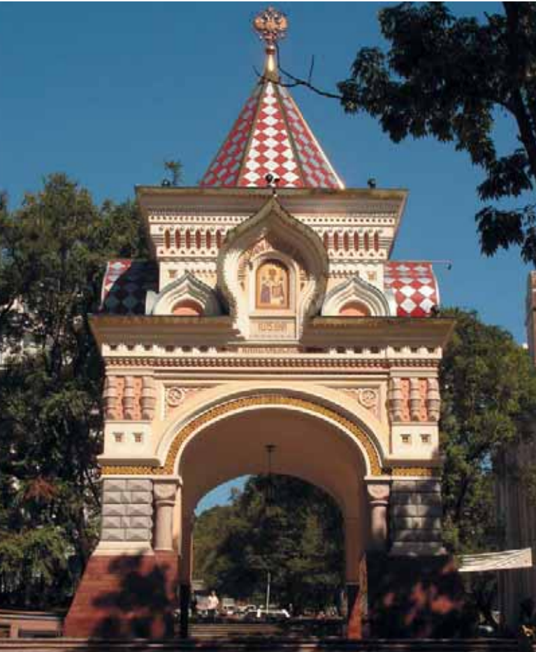
Николаевская триумфальная арка, г. Владивосток. Фасадная краска Кивитекс.
