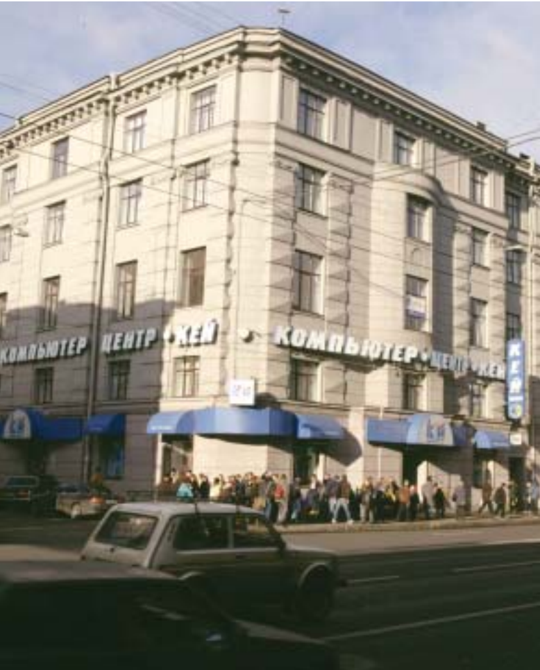
Московский проспект 21, компьютерный центр Кей, Санкт Петербург. Фасадная краска Кивитекс
