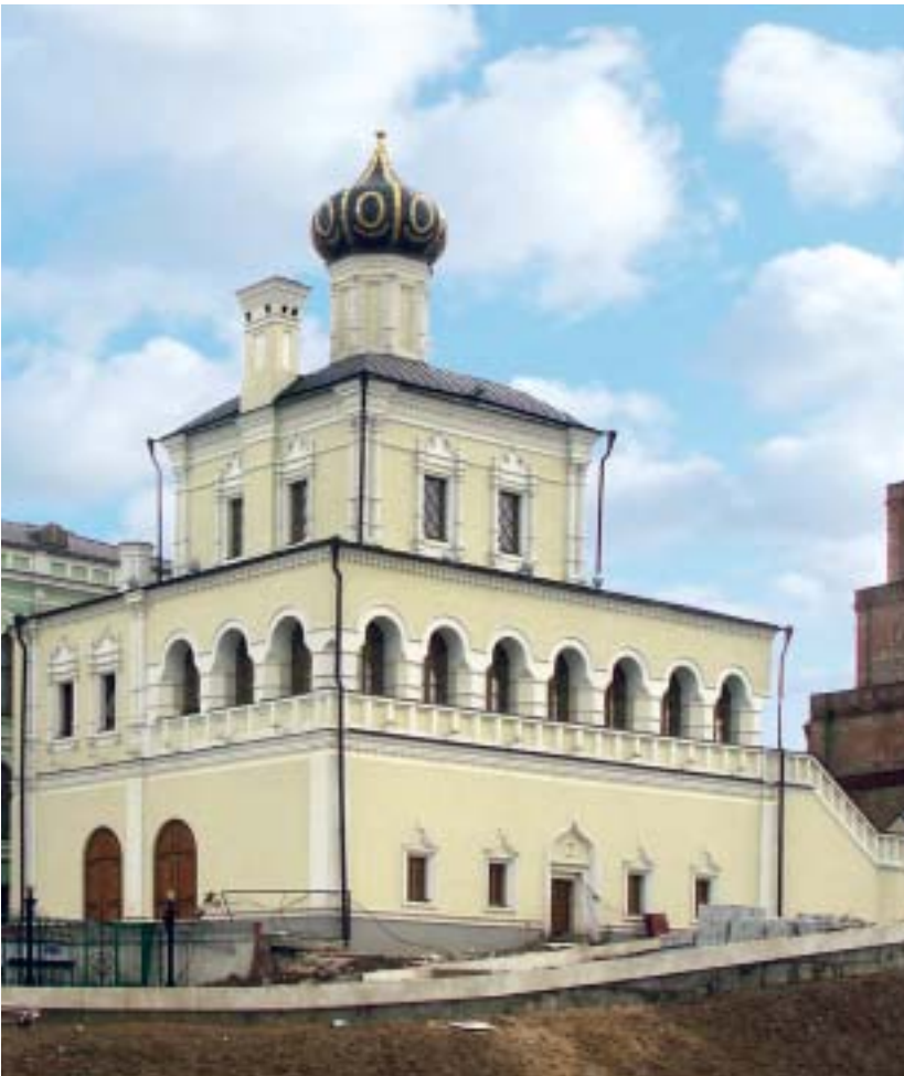
Дворцовая церковь, Казанский Кремль, Казань. Фасадная краска Кивитекс
