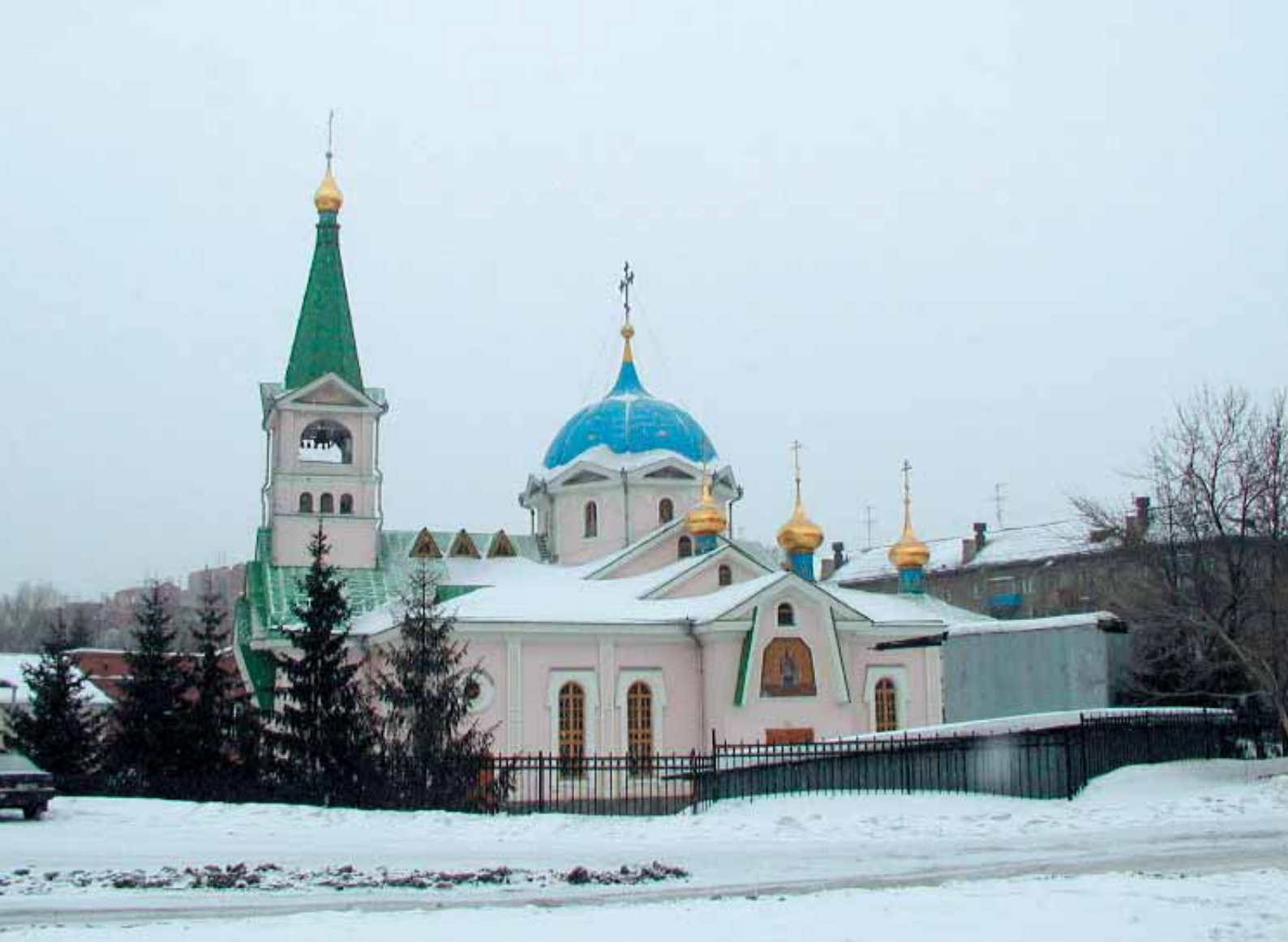
Вознесенский кафедральный собор, Новосибирск. Фасадная краска Кивитекс.
