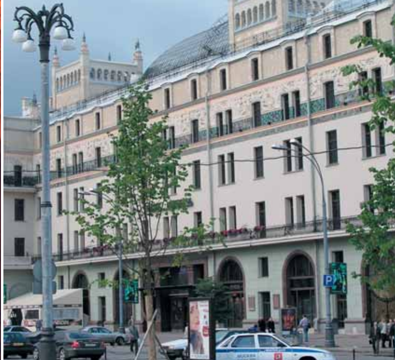
Гостиница "Метрополь", Москва. Фасадная краска Кивитекс.
